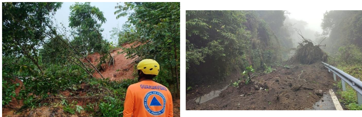
Figure 3 Landslides in Tierras Altas, Chiriquí, Panamá. Photo: Sinaproc 45
